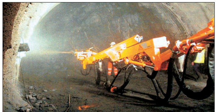
■ Brazo robotizado de gunitado tras desescombro (Putzmeister).
