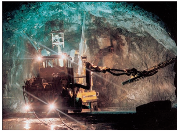
Jumbo perforando la malla para bulonado (Atlas Copco).
