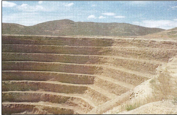
Figura 1. Taludes finales de corta previos a la restauración de la mina Chimney Creek (Nevada, EEUU)
