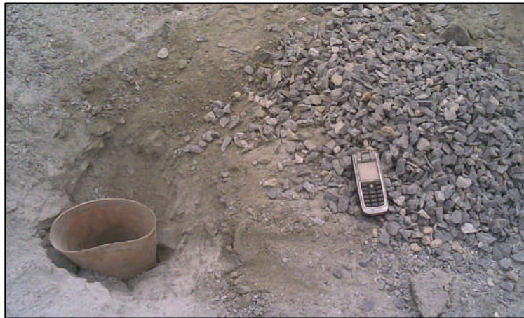
Figura 7: Material de retacado anguloso y de granulometría adecuada para 4 1/3”
